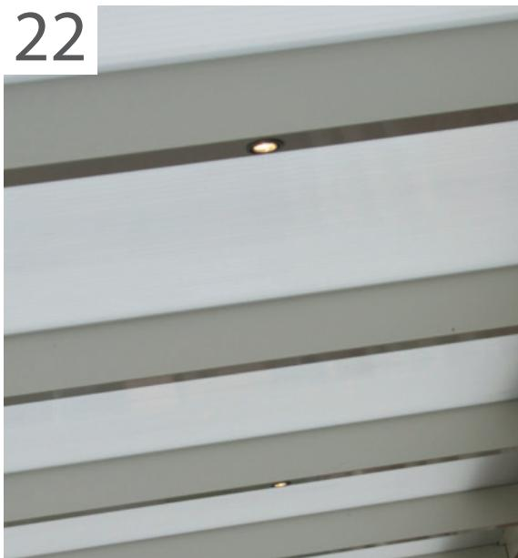
Die Löcher der Led Spots von Pallazzo werden mit 29 mm gebohrt. Zum Anschluss der Verkabelung beachten Sie bitte die Schaltpläne.
