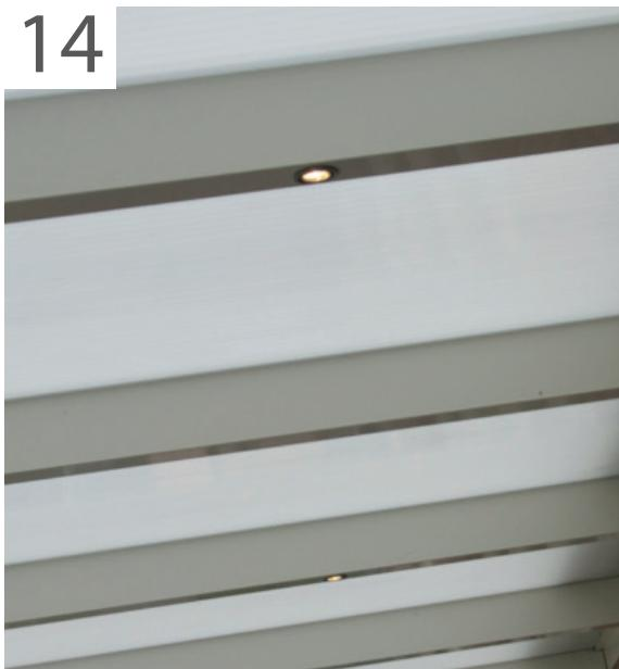
Die Löcher der Led Spots von Pallazzo werden mit 29 mm gebohrt. Zum Anschluss der Verkabelung beachten Sie bitte die Schaltpläne.
