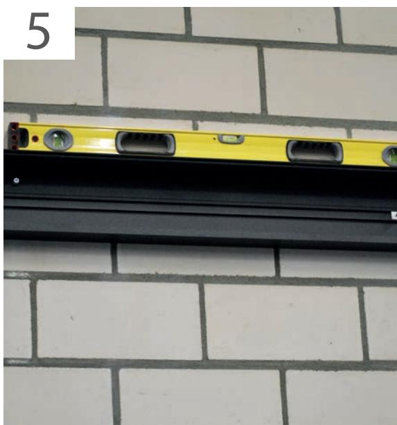
Darauf achten, dass das Mauerprofil waagerecht hängt. Die obere Seite des Mauerprofils abkitten.
