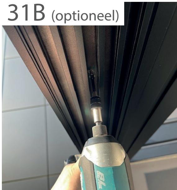
Platzieren Sie das Führungsprofil an der entsprechenden Stelle vorgesehenen Öffnung und achten Sie beim Ausrichten darauf, dass beide Seiten hinter die Pfostenseiten fallen. Durch die vorbereiteten Löcher in der ersten Rinnenwand bohren und anschließend die Teile miteinander verschrauben.
