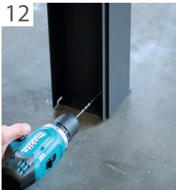
Nachdem die Rinne waagerecht ausgerichtet wurde, bohren und die Pfähle festschrauben. Jetzt kann mit den Dachträgern fortgefahren werden.
