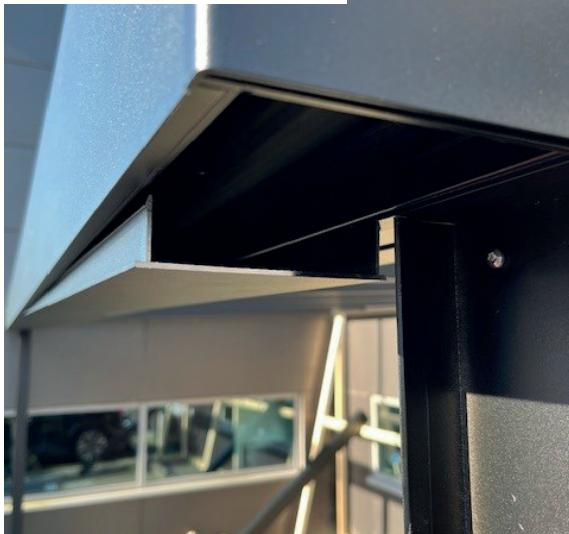
Wenn KEIN INVIGO PRO installiert ist, decken Sie die Öffnung in der Dachrinne mit einem Abdeckstreifen ab. Richten Sie diese so aus, dass beide Seiten hinter die Pfostenseiten fallen und klicken Sie sie in die Öffnung ein.
