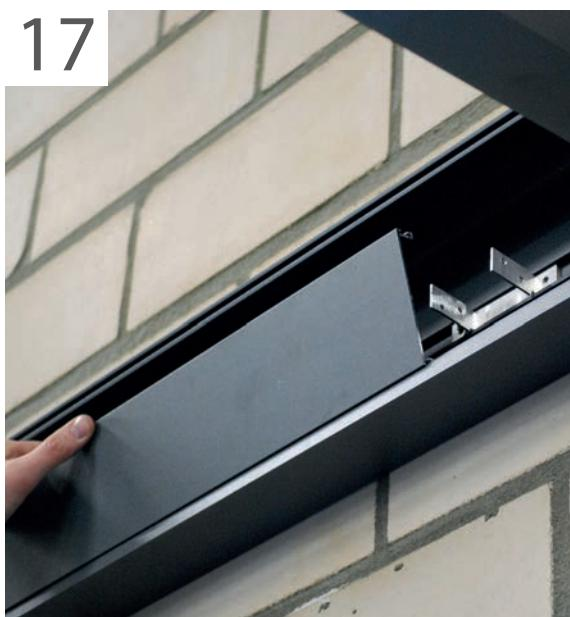
Wenn die Seitenträger montiert sind, das Rinnenerhöhungsstück direkt an die Seitenträger anliegend positionieren.
