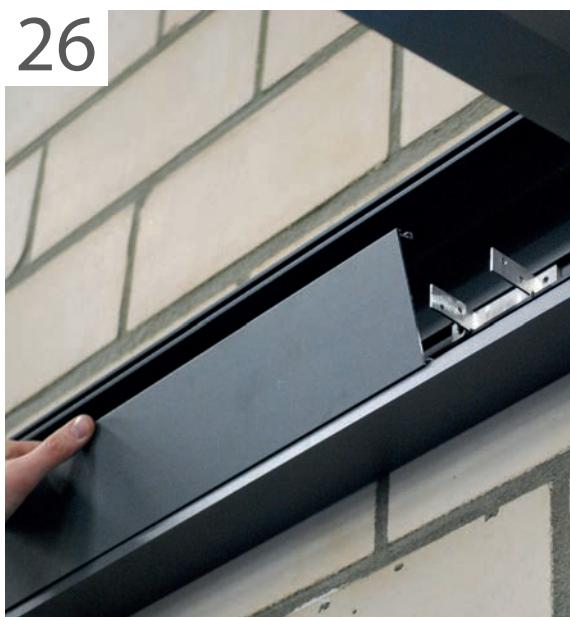
Nachdem die Seitenträger montiert wurden, das Rinnenerhöhungsstück direkt an die Seitenträger anliegend positionieren.
