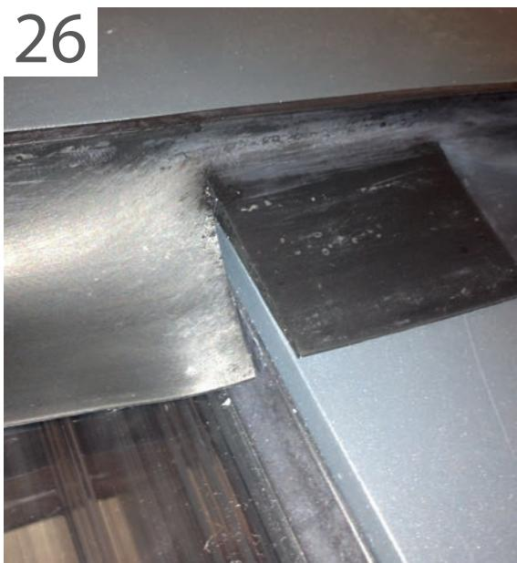
Das Mauergummi jetzt über die erste Scheibe ziehen und auf Höhe der Abdeckleisten einschneiden. Auf diese Weise mit dem gesamten Dach von links nach rechts oder umgekehrt fortfahren. Das Gummi in der Rinne auf die gleiche Weise auf Höhe
