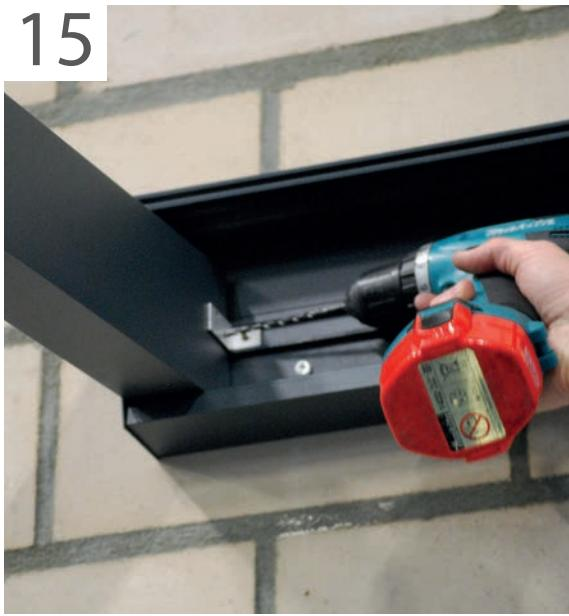
Die Seitenträger werden an den (halben) Bügeln festgeschraubt. Für die Montage der Zwischenträger in den Bügeln werden pro Seite zwei Schrauben verwendet.
