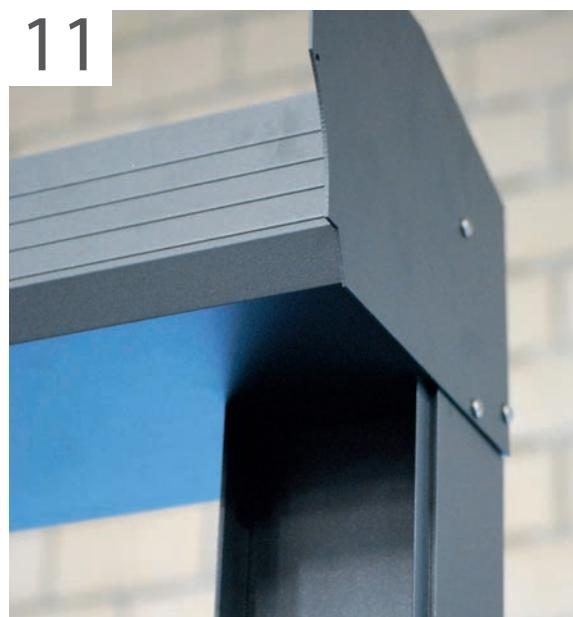
Die Rinne auf die Pfähle legen. Dies geht am besten, wenn alle Vorbereitungen für die Dachträger bereits getroffen wurden, damit direkt mit der Montage der Dachträger fortgefahren werden kann.
