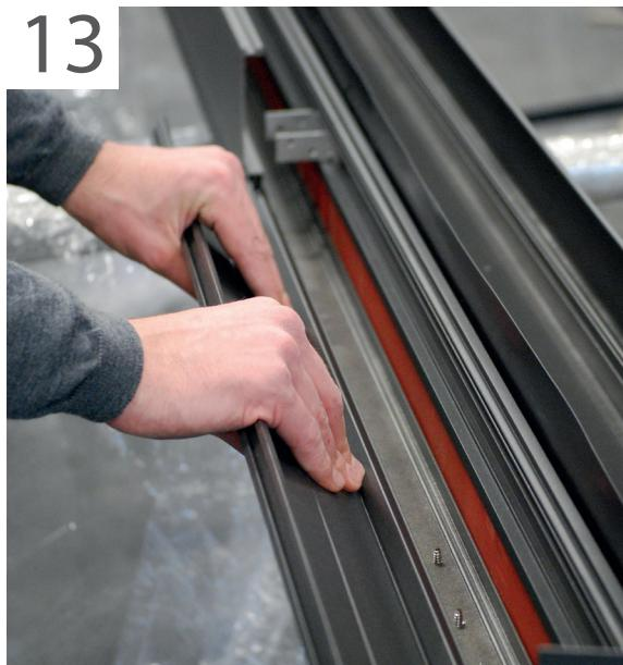
Retirez les rehaussements de gouttière de la gouttière en les tirant vers vous. Montez le support à 55 mm du côté de la gouttière. Faites ceci aux deux extrémités de la gouttière. Si nécessaire, percez un trou de 75 mm pour le drain.
