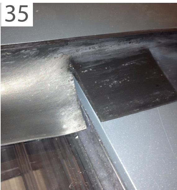
Placez maintenant le caoutchouc mural sur le premier panneau et coupé à hauteur des bandes de recouvrement. De cette façon, avec tout le toit de continuer de gauche à droite ou vice versa. Le Caoutchouc dans la gouttière de la même manière à la hauteur.
