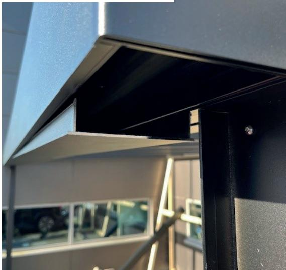
Si AUCUN INVIGO PRO n'est installé, couvrez l'ouverture dans la gouttière avec une bande de protection. Alignez-les de manière à ce que les deux côtés tombent derrière les côtés du poteau et enclenchez-les dans l'ouverture.
