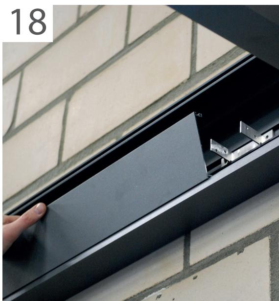
Une fois les supports latéraux montés, le Rehausseur de gouttière directement sur les supports latéraux placez-le à proximité.
