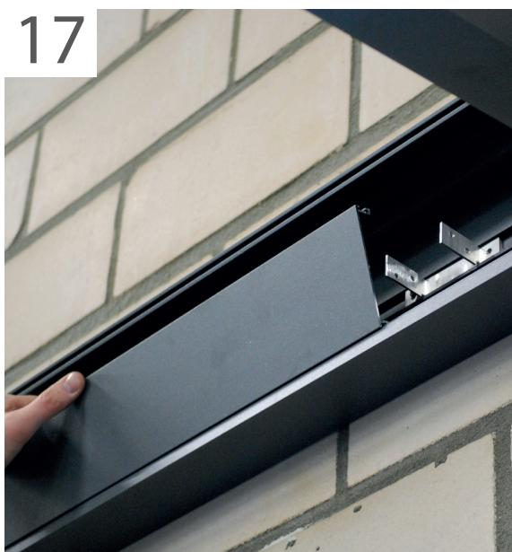
Lorsque les supports latéraux sont montés, la colonne montante de gouttière est directement adjacente aux supports latéraux position.
