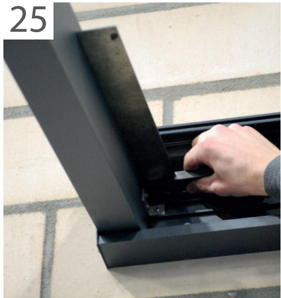
Assurez-vous que le toit est aligné à angle droit afin que les supports soient à angle droit rester. A cet effet, si nécessaire, une mesure d'angle ou utiliser une autre méthode pour Pour déterminer la perpendicularité.
