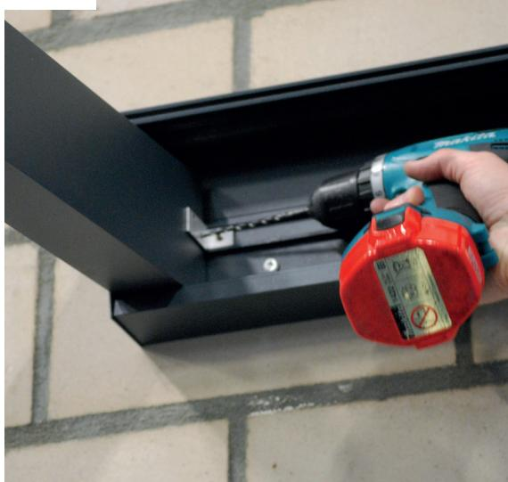
Les supports latéraux sont fixés aux (demi) supports bien vissé. Deux vis sont utilisées par côté pour monter les supports intermédiaires dans les supports.
