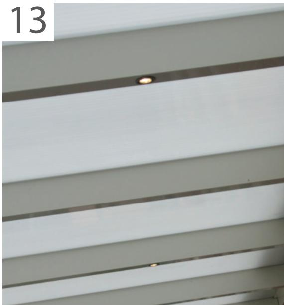
Les trous des spots Led de Pallazzo sont percé de 29 mm. Pour connecter le Pour le câblage, veuillez vous référer aux schémas de circuit.
