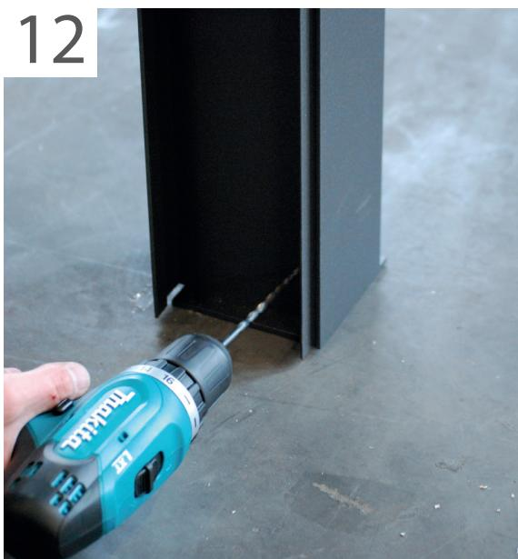
Une fois la gouttière alignée horizontalement les poteaux ont été percés et vissés. Maintenant peut continuer avec les barres de toit.
