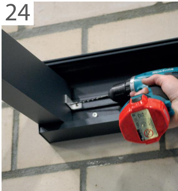
Les supports latéraux sont fixés aux (demi) supports bien vissé. Deux vis sont utilisées par côté pour monter les supports intermédiaires dans les supports.
