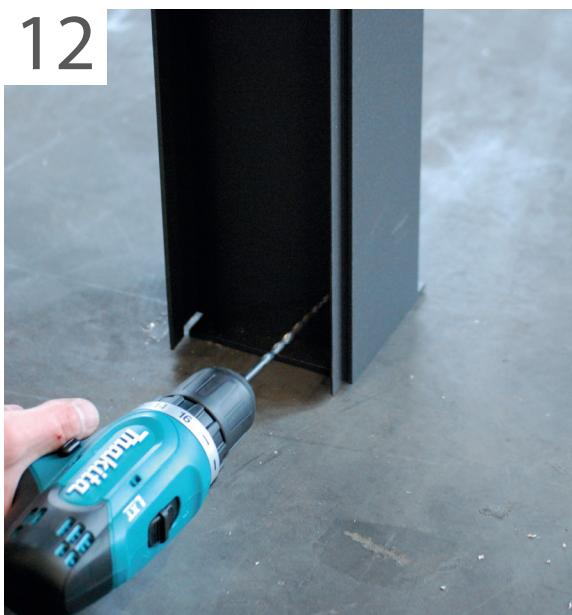
Une fois la gouttière alignée horizontalement les poteaux ont été percés et vissés. Maintenant peut continuer avec les barres de toit.
