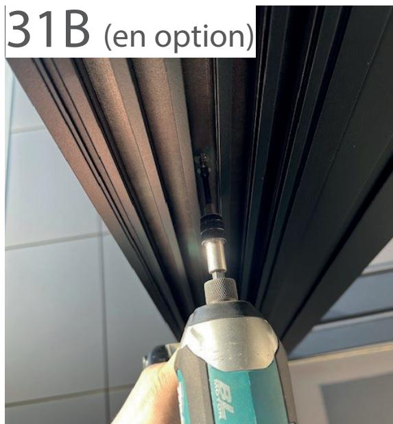
Placez le profilé de guidage dans l'ouverture appropriée et assurez-vous que les deux côtés tombent derrière les côtés du poteau lors de l'alignement. Percez les trous préparés dans la première paroi de la gouttière, puis vissez les pièces ensemble.
