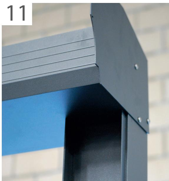
Placez la gouttière sur les poteaux. C'est sur il est préférable que toutes les préparations pour les barres de toit aient déjà été faites afin que vous puissiez commencer l'installation des barres de toit peut être poursuivie peut.
