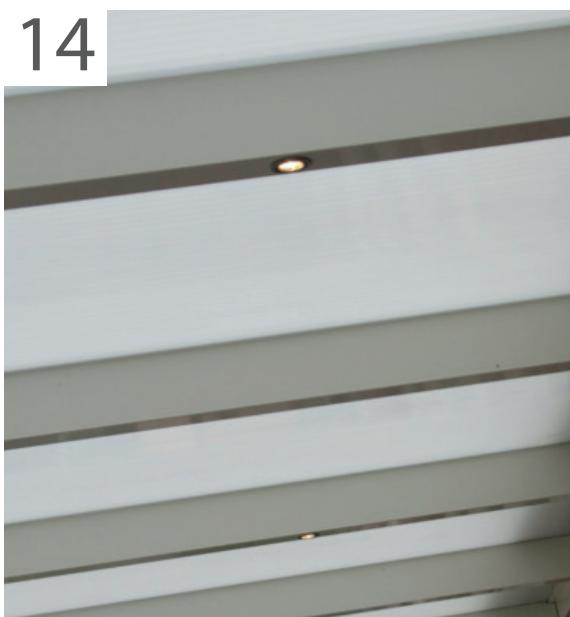
Les trous des spots Led de Pallazzo sont percé de 29 mm. Pour connecter le Pour le câblage, veuillez vous référer aux schémas de circuit.
