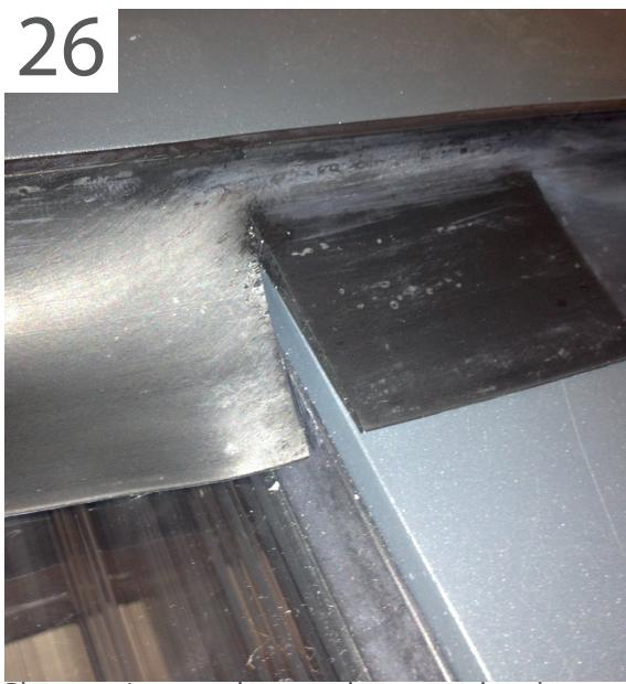
Placez maintenant le caoutchouc mural sur le premier panneau et coupé à hauteur des bandes de recouvrement. De cette façon, avec tout le toit de continuer de gauche à droite ou vice versa. Le Caoutchouc dans la gouttière de la même manière à la hauteur
